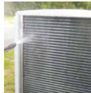
Después de la limpieza se debe comprobar visualmente el evaporador por si tuviera rastros de corrosión o daños. Los tubos de cobre del evaporador no deben estar acodados.
