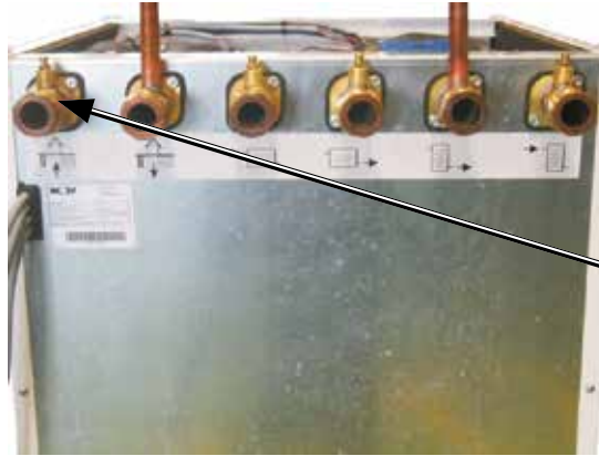
Purgador manual en la entrada de glicol
