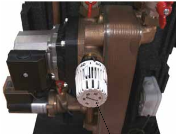
termostatický regulátor s konštantne nastavenou teplotou
