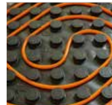
Podlahové vytápění/ chlazení 1.2.3 Mokrý systém
