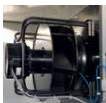
3 Ventilátory s EC motorom s integrovaným regulátorom objemového prietoku
