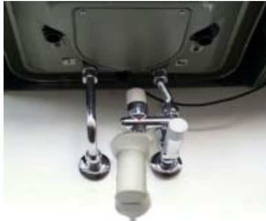
SW-70 mit montierter Sicherheitsgruppe
