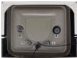
Entlüftungsventil für Heizschlange
