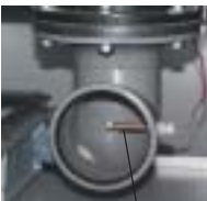
Abgastemperaturfühler im Kunststoffbogen
