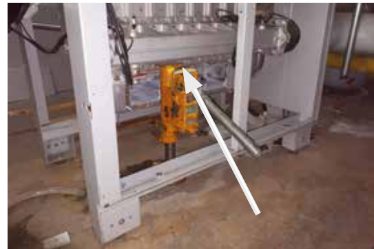
Stempelwagenheber unter Rücklaufrohr
