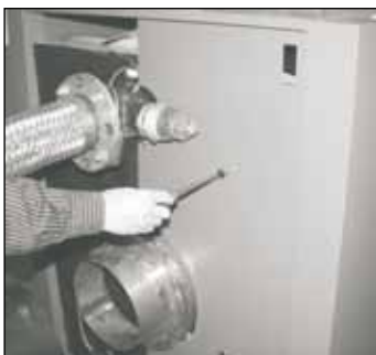
Verschraubung der hinteren Verkleidungsbleche an das Gushinterglied
