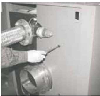
Verschraubung der hinteren Verkleidungsbleche an das Gushinterglied
