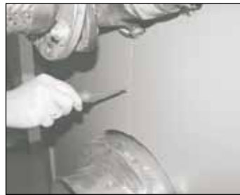
Verschraubung der Verkleidungsbleche zueinander
