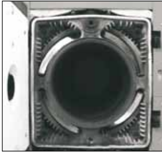
Gesamtansicht mit Turbulatoren eingelegt
